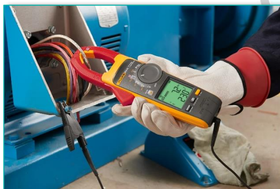
Figura 4: Medición de la corriente eléctrica de un conductor mediante la pinza amperométrica [1].
