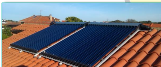
Figura 7: Colector solar en el techo de una casa [10].
